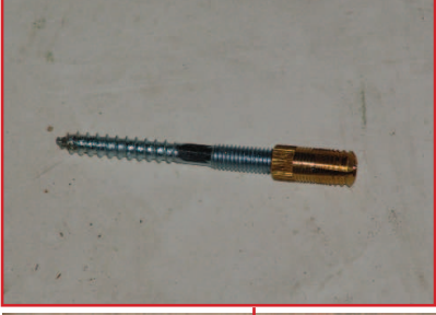
De oude centrale verankering in het medaillon werd vervangen door een nieuwe systeem.
