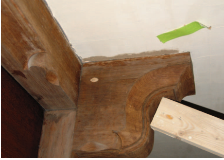
Het herbevestigen van loszittende consoles m.b.v. een houten dook.
