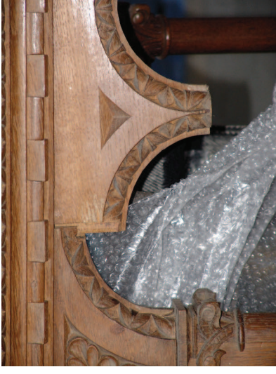
De naar beneden gezakte bovenste regel van de constructie (communicabank : zijbeuk links).
