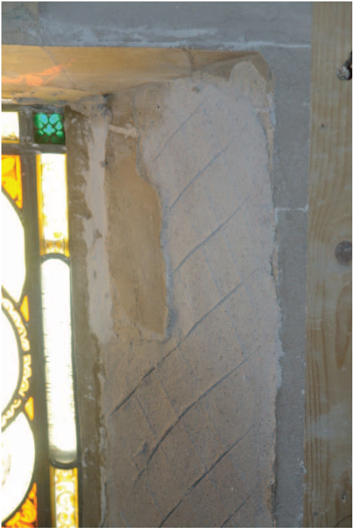
Grove mortellaag onder niveau (Statie 9)
