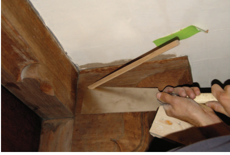
Het herbevestigen van loszittende consoles m.b.v. een houten dook.
