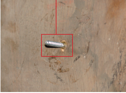
De oude centrale verankering in het medaillon werd vervangen door een nieuwe systeem.
