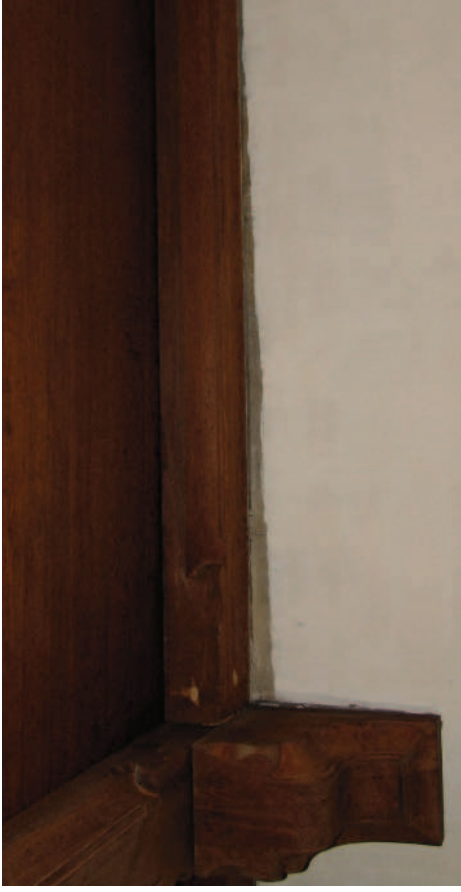
Het herbevestigen van verschoven moerbalken m.b.v. een houten dook.
