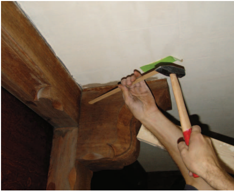
Het herbevestigen van loszittende consoles m.b.v. een houten dook.
