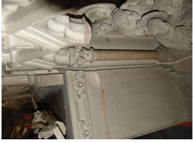
Constructurele verschuivingen van de stenen onderdelen.
