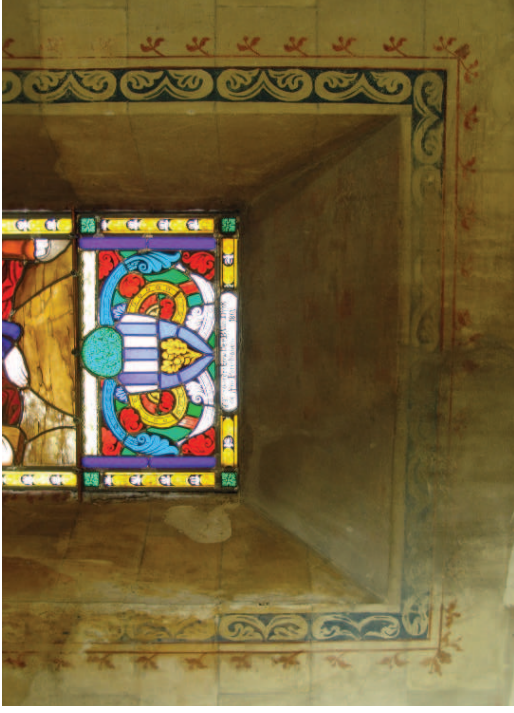
Vochtschade, ververlies, lacunes in de pleister en barsten (statie 7)
