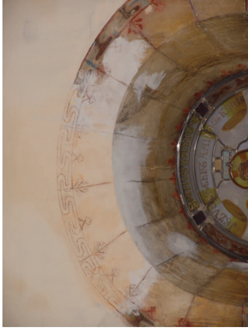
De aangebrachte tekening m.b.v. het doorprikte kalkpapier en een pigmentkussen (Stafie 12)
