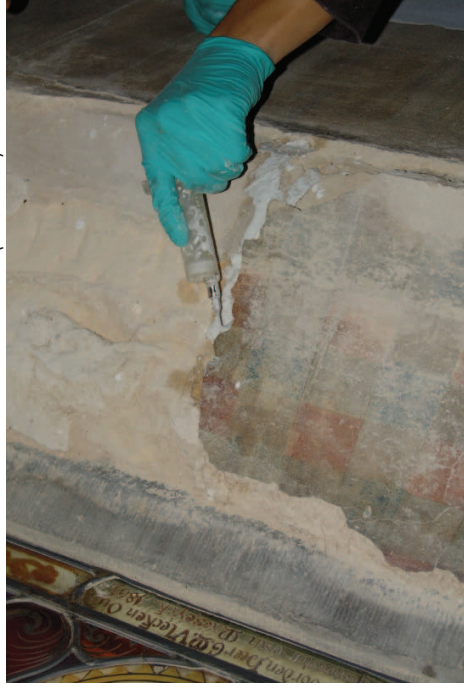
Fixatie van de losse delen (Statie 12)
