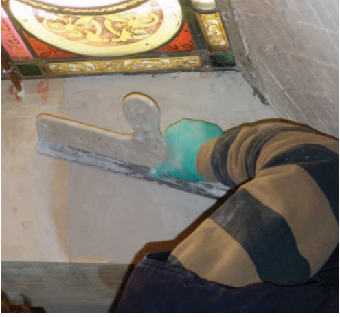
Het op niveau brengen van de fijne afwerkingsmortel (Statie 9)
