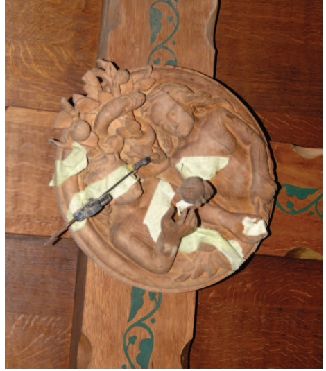
Het verwijderen van de loszittende delen.
